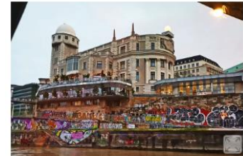
Die Urania über üppigen Graffiti an der Kaimauer
